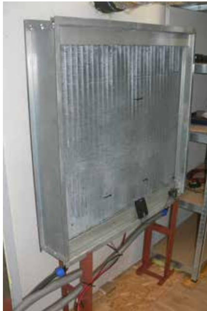
Obr. 1 Výmenník tepla na chladenie studňovou vodou
