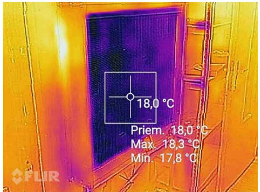
Obr. 3 Termovízia výmenníka – chladenia studňovou vodou
